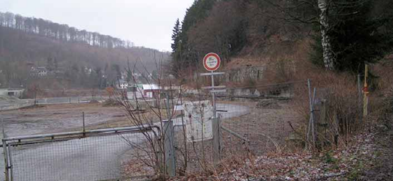
Industriebrache- nördlicher Teilbereich
